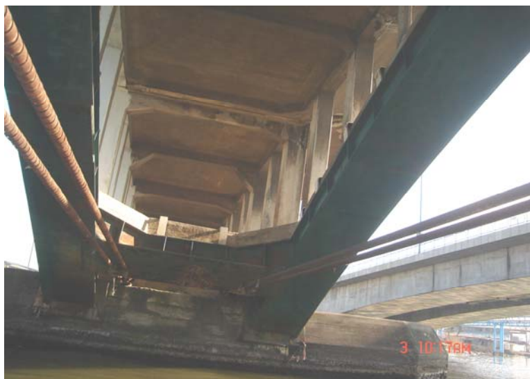
تصویر زیر اتصال تیر ورق به کلاhek شمع را نشان می دهد
