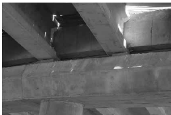
جانمایی نادرست تکیه گاه نتوپرن در پایه ها
