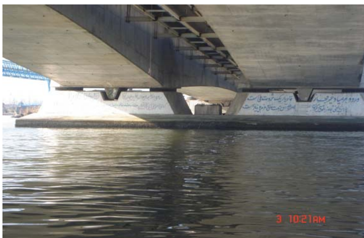
جانمایی نادرست تکیه گاه نتوپرن در پایه ها
